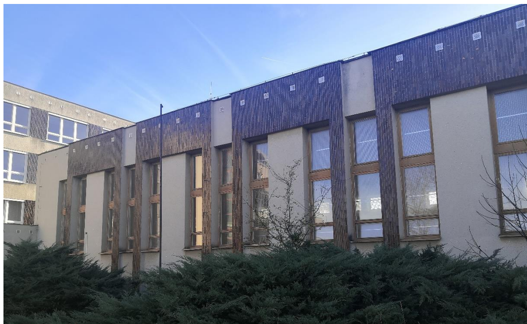
Obrázek 8 – Severní fasáda – tělocvična (opadávající kabřincový obklad)
